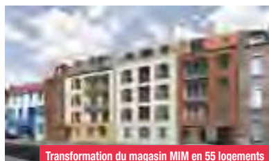
Transformation du magasin MIM en 55 logements
