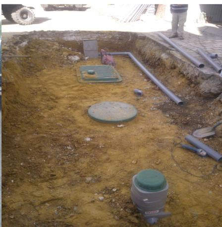
Photo 2 : installation après remblaiement
