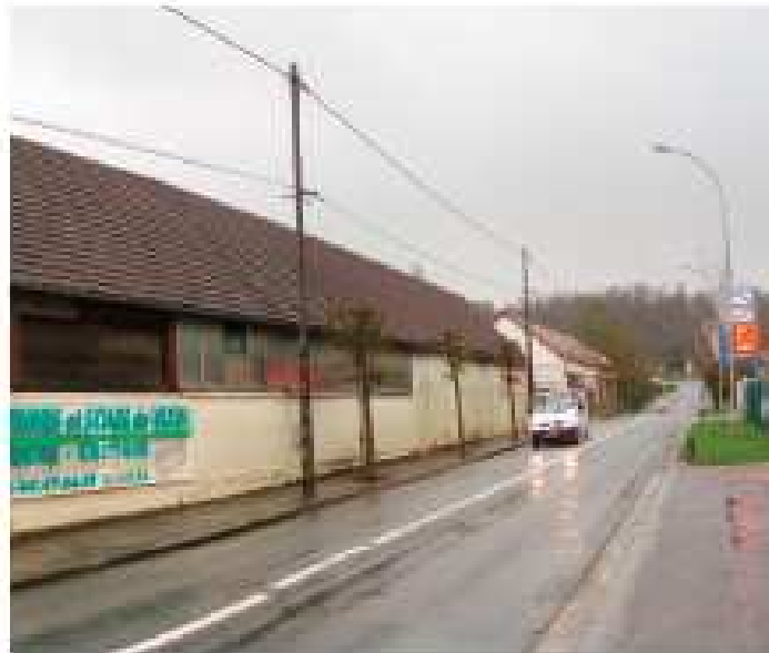
Front bâti des entrepôts depuis la RD981 (en face de la station essence)
