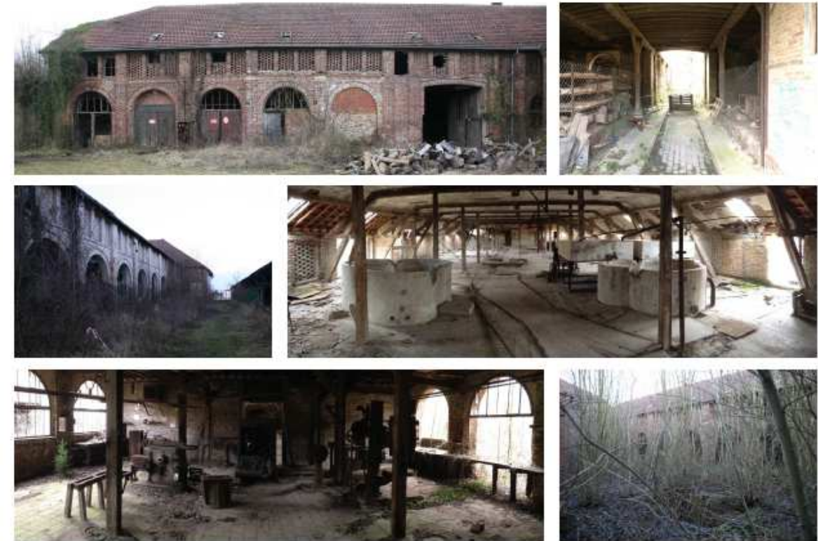
Photographies du bâtiment d'exploitation (Source : Tandem +)
