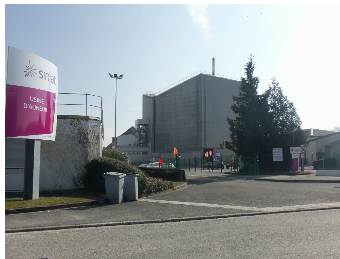
Usine SINIAT dans la zone industrielle de Sinancourt (Source : Anaïs SOKIL, MEDIATERRE Conseil, mars 2015)
