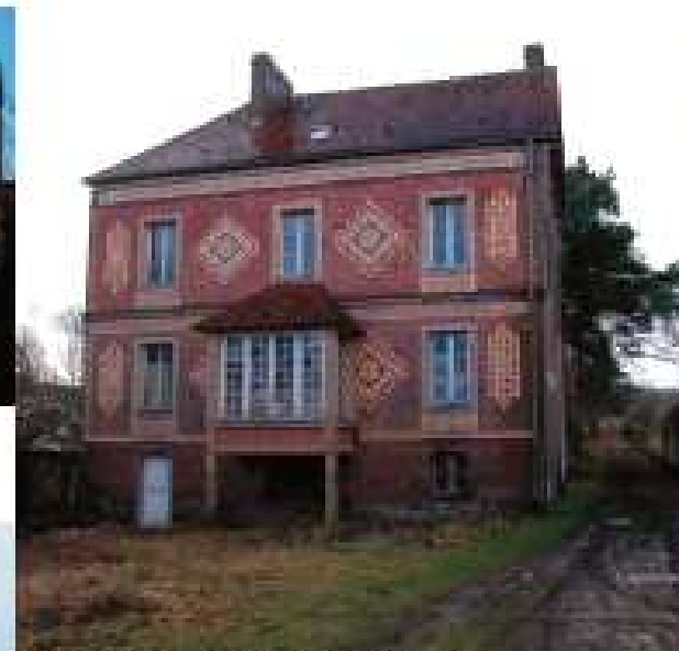
Maison de direction du site Boulenger
