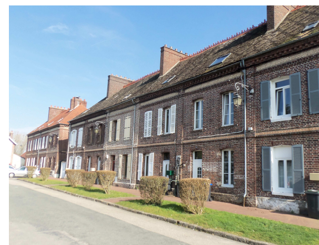
Zone bâtie, rue de la gare (Source : Anaïs SOKIL, MEDIATERRE Conseil, mars 2015)
