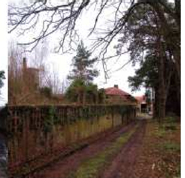
Mur de soutènement
