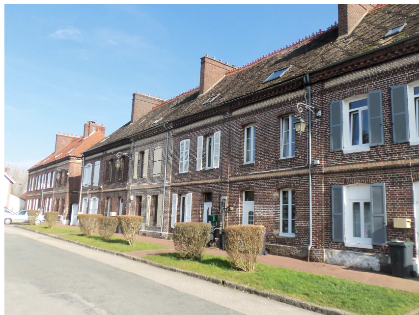
Logements anciens rue de la gare (Source : A. SOKIL, MEDIATERRE Conseil Mars 2015)
