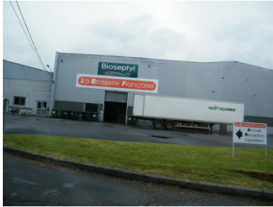
Partie bâtiments industriels – zone Nord – Bâtiment principale
