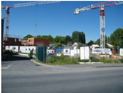
Projet de construction de logements en cours de réalisation
