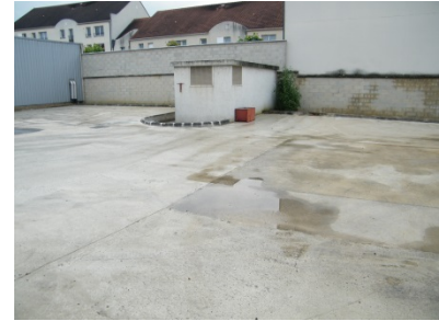
Partie bâtiments industriels – zone Nord – Transformateur Ouest
