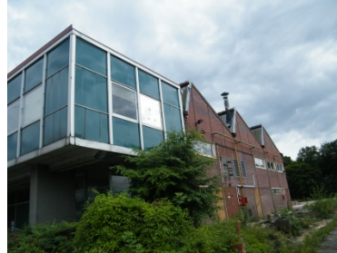
Bâtiment en attente de démolition
