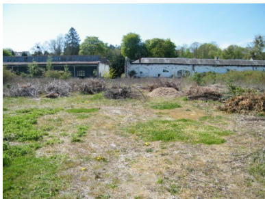
Partie bâtiments industriels – zone Sud – Bâtiment démolli – dépôt déchets verts
