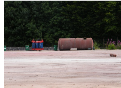
Cuve retirée et stockée en attente d'évacuation
