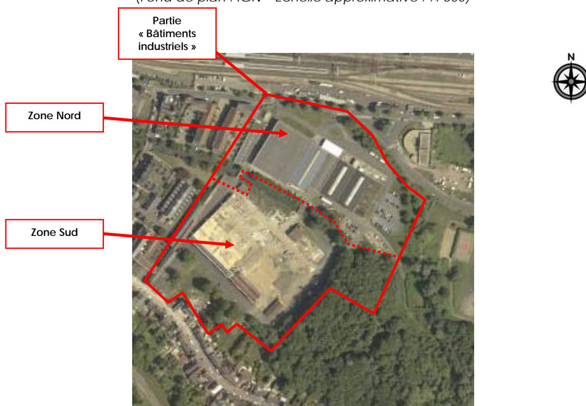
Figure n°9 : découpage de la partie « Bâtiments industriels » (Fond de plan : IGN – Echelle approximative : 1/4 500)
