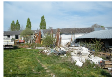
Secteur 4 - Partie arrière
