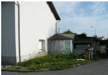
Secteur 4 - Bâtiment à usage d'habitation et cuve de fuel
