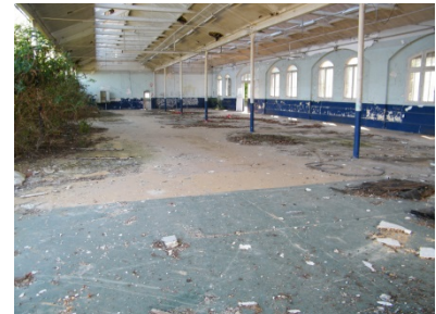
Partie bâtiments industriels – zone Sud – Intérieur ancien magasin produits finis
