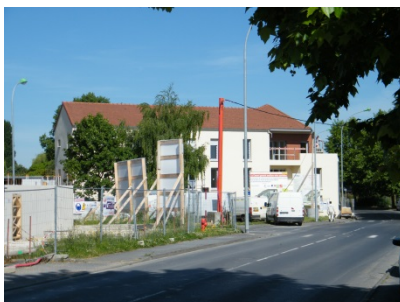
Secteur 6 - bâtiment à usage d'habitation en cours de finalisation
