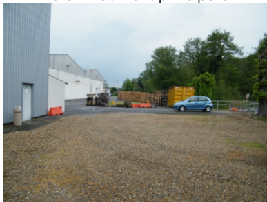
Partie bâtiments industriels – zone Nord – Zone dépôt
