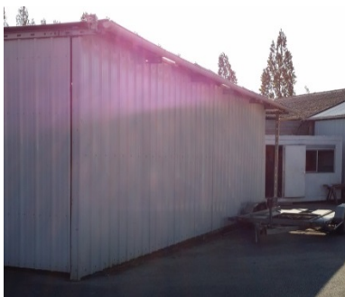
Secteur 5 - Bâtiment Sud et bâtiment modulaire
