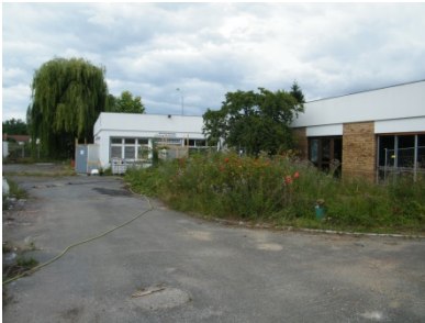
Bâtiment en attente de démolition
