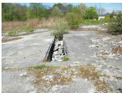
Fosse bétonnée dans la partie Ouest
