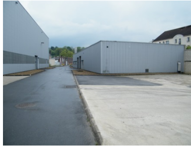
Partie bâtiments industriels – zone Nord – Bâtiment annexe
