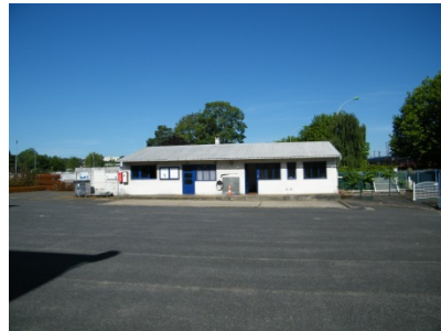
KDI Nozal – Bâtiment annexe
