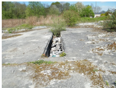
Fosse bétonnée dans la partie Ouest
