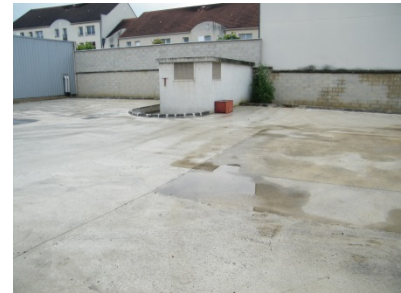
Partie bâtiments industriels – zone Nord – Transformateur Ouest
