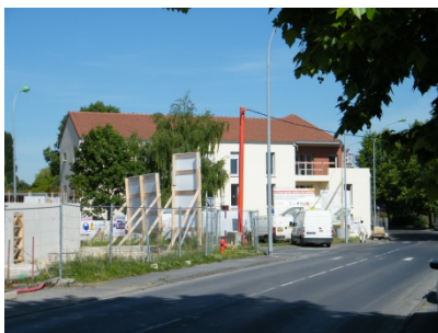
Secteur 6 - bâtiment à usage d'habitation en cours de finalisation
