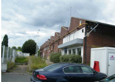
Bâtiment avec local sécurité + postes de livraison gaz et électricité (à gauche)
