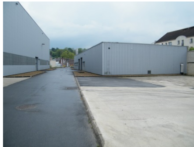
Partie bâtiments industriels – zone Nord – Bâtiment annexe
