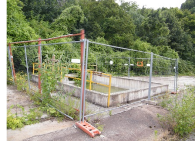
Fosse eaux pluviales
