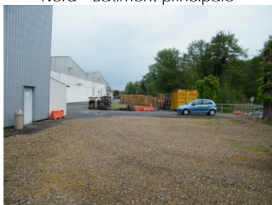
Partie bâtiments industriels – zone Nord – Zone dépôt
