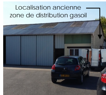
Secteur 5 - Bâtiment Ouest (présence, anciennement, d'une station de distribution et cuve gasoil)
