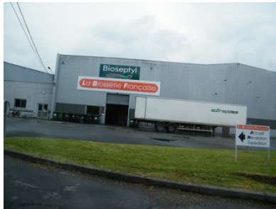
Partie bâtiments industriels – zone Nord – Bâtiment principale
