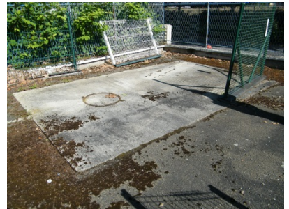
KDI Nozal – Emplacement supposé ancienne cuve de carburant
