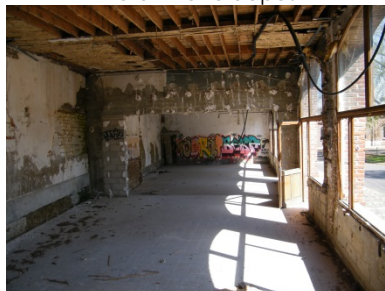
Partie bâtiments industriels – zone Sud – Intérieur bâtiment en limite Ouest du site
