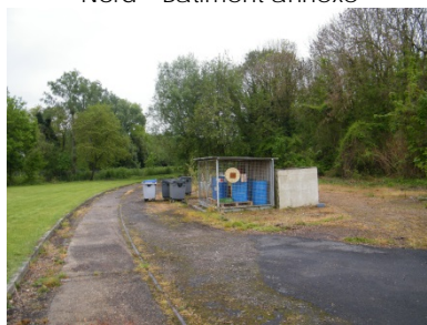
Partie bâtiments industriels – zone Nord – Zone dépôt
