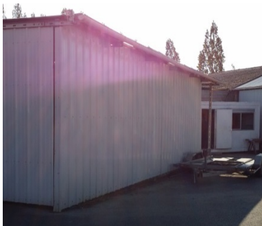
Secteur 5 - Bâtiment Sud et bâtiment modulaire
