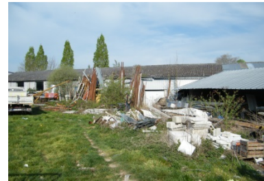
Secteur 4 - Partie arrière
