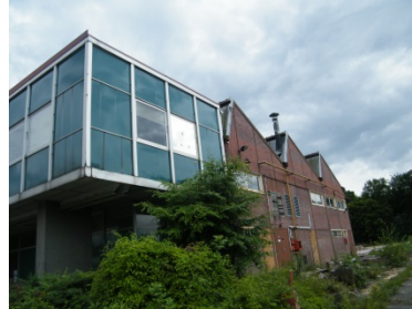
Bâtiment en attente de démolition
