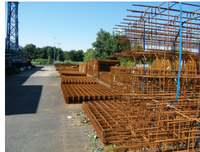
KDI Nozal – Dépôt armatures métalliques
